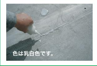
数時間で、 KIT-BENRY樹脂は プラスチック状に固まります。 雨になれば、固まっている樹脂が、 徐々に溶け出し、 雨漏りをしているひび割れに雨と共に侵入、 晴れれば、その成分が固ます。 ひび割れ部分に、徐々に滞積固着します。 晴れ雨を繰り返す事で、 最終的には、ひび割れが塞がり、 雨漏りが無くなると云う仕組みなのです。 この効果が得られます。 より効果が得られます。 オーバーコート塗料ではありません。⊠
